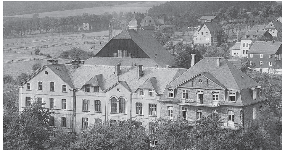
Der Anbau von 1928 mit der Josef-Statue ganz rechts wurde von dem Abriss verschont und mit in das neue Gebäudekonzept integriert.
