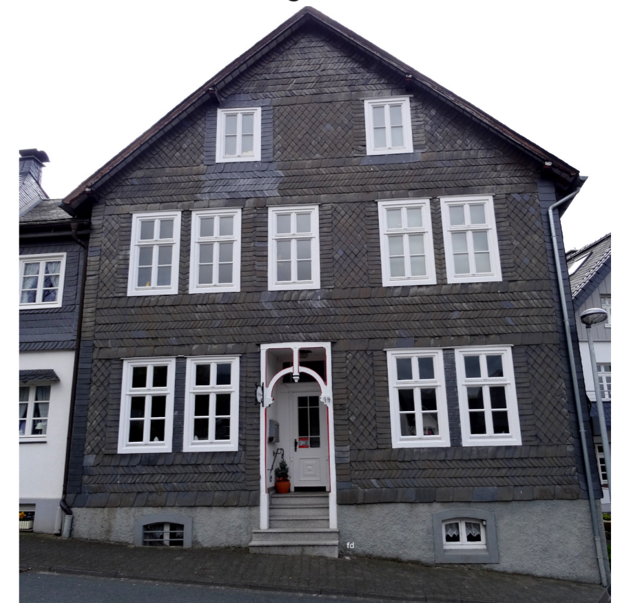
Das Haus steht heute aufgrund seiner Bauart unter Denkmalschutz.
