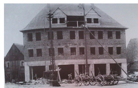
Bau des Hochhauses 1928-1929
